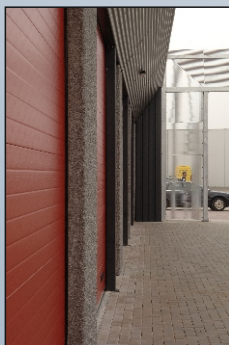
VOORBEELD AANSLAG OVERHADDEUR-BETONBLOK
