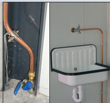
Uitstortgootsteen met kraan en aftapkraan
